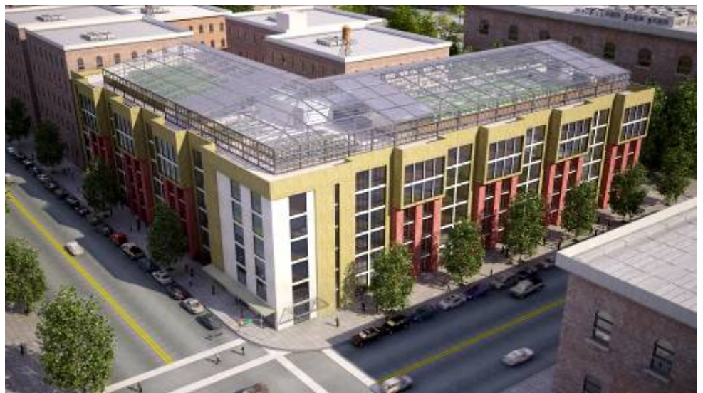
Im Gebäudekomplex »Blue Sea Developments«, New York City, wird zurzeit ein Modell der integrierten Landwirtschaft umgesetzt. Foto: BrightFarm Systems
